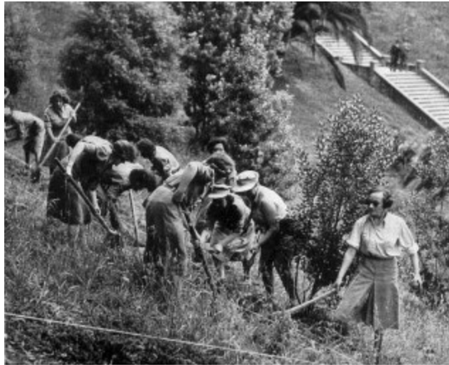
W.W.S.A. DIG TRENCHES
